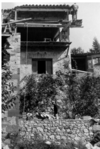
Recrecido de la fachada y terrazas parte delantera
