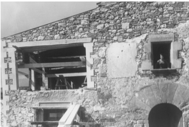
Recrecido de la fachada y terrazas parte delantera
