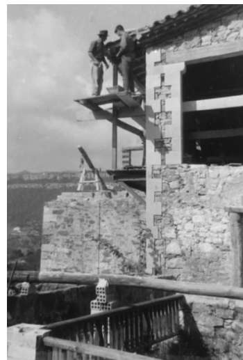
Recrecido de la fachada y terrazas parte delantera
