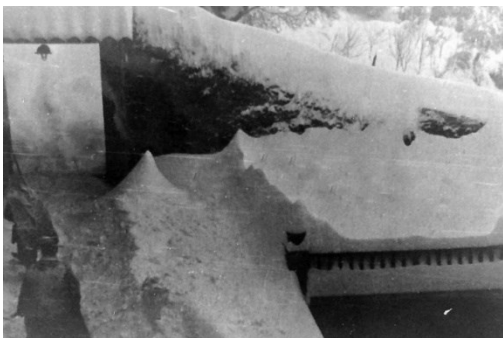
Patio de delante
